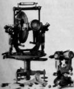
Mit neuen Ideen revolutionierte Heinrich Wild die Vermessungstechnik. Der kleine Universaltheodolit Wild T2 (rechts im Bild) löst die klassischen Aufgaben wie die Triangulations-Theodolite aller Bauarten (links) und muss trotz seiner Kompaktheit präziser, schneller und zuverlässiger sein.
