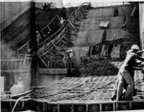
Auf der grössten Baustelle der Welt, in Itaipu, verlassen sich die Ingenieure auf das Nivellier Wild N2, für das der berühmte Schweizer Erfinder die einzigartige Wendelbelle entwickelt hat.
