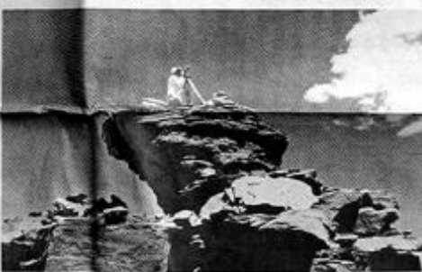
Geodäten in aller Welt nehmen Messungen mit Schweizer Vermessungsinstrumenten. Für eine neue Karte des infimsten Teils vom Grand-Canyon-Nationalpark, Arizona/USA wurden die Triangulationsarbeiten mit einem Präzisions-Theodolit Wild T3 durchgeführt, der unter anderem auch die Gipfelhöhe der Mount Everest bestimmte.
