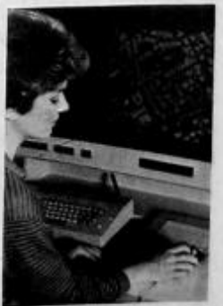
Die dynamisch-digitale Karte des Informap-Systems ist im Computer gespeichert und verfügt über geometrische und administrative Daten mit hoher Flexibilität. Solche Landinformationssysteme bilden zu den neuesten Entwicklungen im Vermessungswesen.
